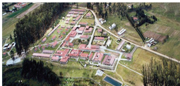
Figura 2 Foto aerea dell'intero complesso. Il compound comprende l'ospedale vero e proprio e le strutture di supporto: officina meccanica, falegnameria, "cava" per la preparazione di materiale da costruzione, fattoria, panificio e abitazioni del personale.
